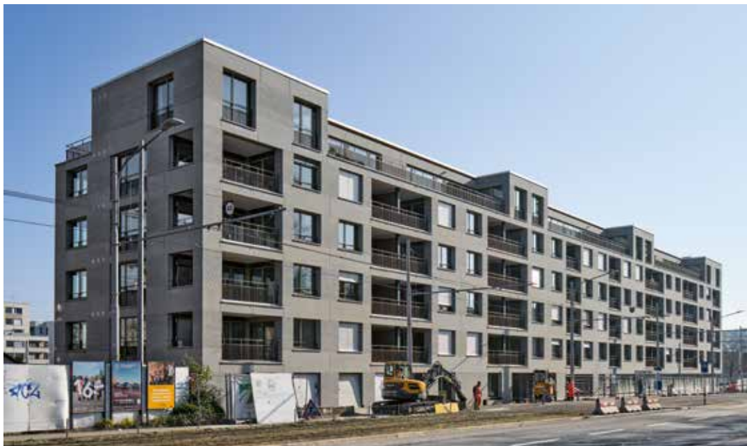
Der Mattenhof III weist eine selbsttragende Fassade aus Bollinger Sandstein auf. Das Tragwerk des Gebäudes ist in Stahlbeton ausgeführt.
