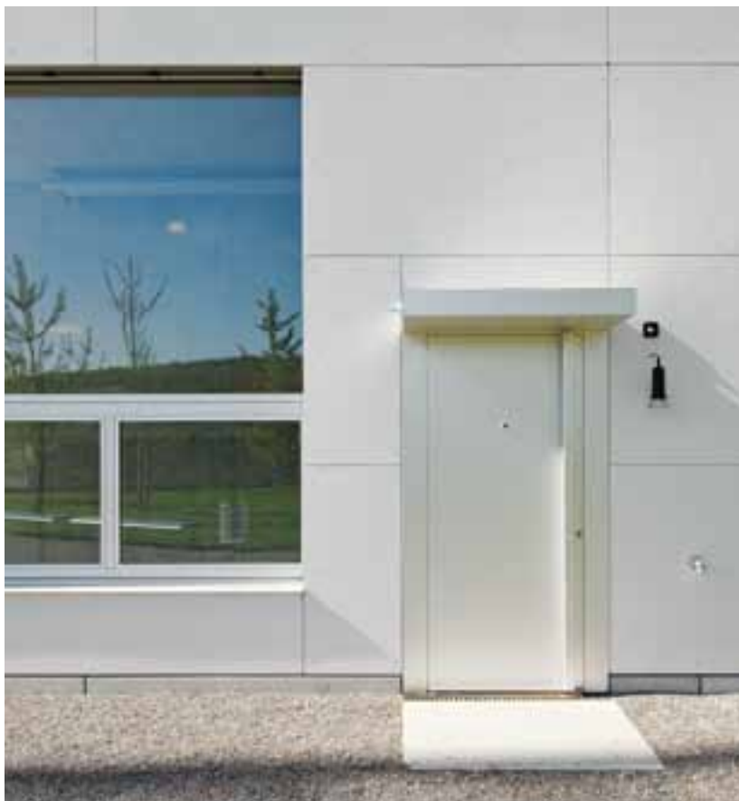
Hinterlüftete Leichtbaufassaden mit Eternitplatten definieren einen präzise geschnittenen Baukörper und unterstützen die Identität des eigenwilligen Gebäudes.
